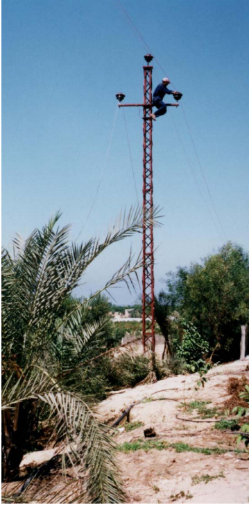
صورة ١: خطو يتم ط الضغط لعالي رفعا على أبراج الكهرباء.
