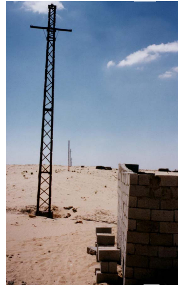
صورة ٢: تم إقامة أبراج لكهرباء وبناء غرفة للمحول.
